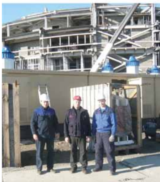
Монтаж КРТП Mistral г. Сочи, Олимпийский объект: Малая Ледовая Арена
