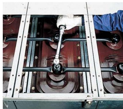
Изолированные шины установлены параллельно. Присоединение осуществляется к верхним контактным площадкам трехпозиционного аппарата с использованием распределителя поля и с помощью невыпадающего винта. Номинальный ток сборных шин 630 или 1250 А.
